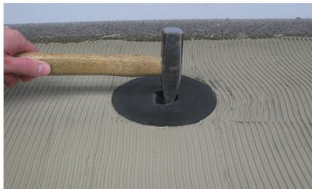
**5** Nach Trocknung des Estrichs Fliesenkleber mittels 4 mm Zahnkelle um den Bodenablauf aufziehen, Bauschutzkappe mittels Hammer an Sollbruchstelle einschlagen und herausziehen.
