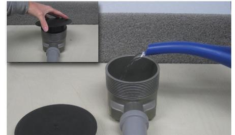
**3** Nach Aushärtung des Fliesenklebers Blanke DIBA-CUBE mit einem Gefälle von ca. 2 % an die Hausentwässerung anschließen und auf Dichtheit überprüfen. Bauschutzkappe im Anschluss einsetzen.
