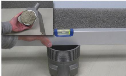
**2** Einbauposition am Untergrund säubern, Ablaufgehäuse mit Fliesenkleber am Untergrund fixieren und in Waage ausrichten. Rohrmuffe bei der Einbauhöhe berücksichtigen und ggfs. einstellen.
