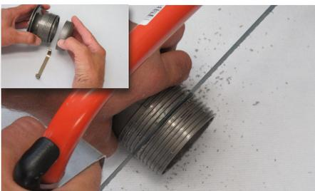
**7** Aufstockelement unter Berücksichtigung der Fliesenstärke winkelig in die Gummidichtung einsetzen. Metallspange des Siphons lösen, Deckel und Dichtung entnehmen. Mittels Eisensäge auf das Einbaumaß von Ablaufkörper und Aufstockelement kürzen, wieder zusammensetzen und in das Aufstockelement einstecken.
