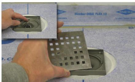
**8** Haarsieb in den Geruchsverschluss einsetzen und durch 90° Drehung arretieren. Abdeckung aus Edelstahl in das Aufstockelement einlegen.
