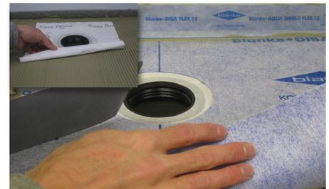
**6** Dichtgummi mit werkseitig aufgebracht Abdichtungsvlies in das Ablaufgehäuse einsetzen. Abdichtungsvlies ausbreiten und in den Fliesenkleber einbetten. Im Anschluss Verbundabdichtung BLANKE DIBA nach unserer Verlegeanleitung einbauen.
